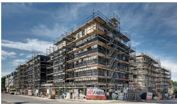
In der Wiesbadener Wohnanlage errichtete Faber Bau Gebäude nach verschiedenen energetischen Standards, unter anderem als Passivhaus und KfW-Effizienz-55-Haus
