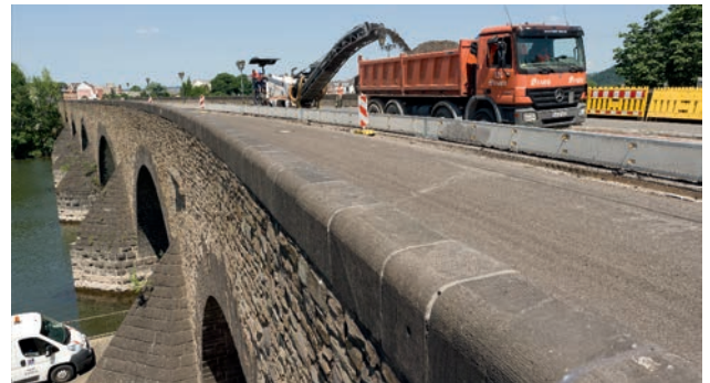
In Koblenz saniert Faber Bau die Balduinbrücke, einen 500 Meter langen Brückenzug bestehend aus einer historischen Bogenbrücke und diversen neueren Konstruktionen über die Mosel
